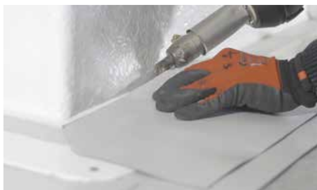
Einfache Montage der LAMILUX Aufsatzkränze dank PVC-Anschlussschiene
