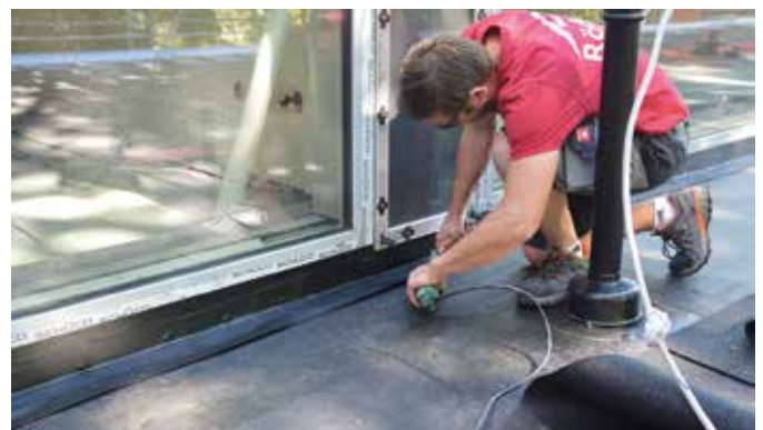
Händisch verschweißt: Anschluss an die bodentiefe Fensterfront auf dem Dach (Anschluss Verglasung)
