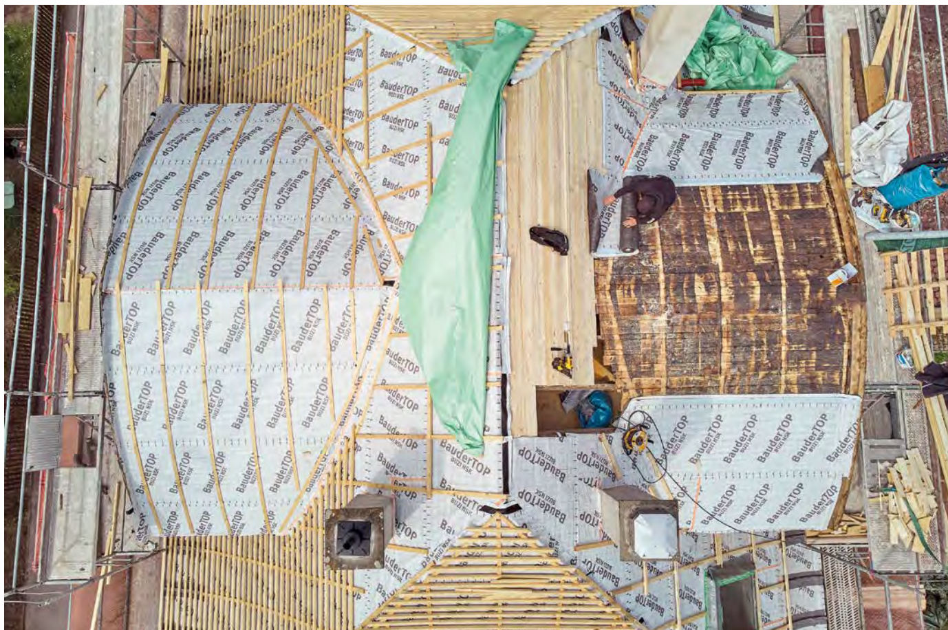
BauderPIR als Aufsparrendämmung
