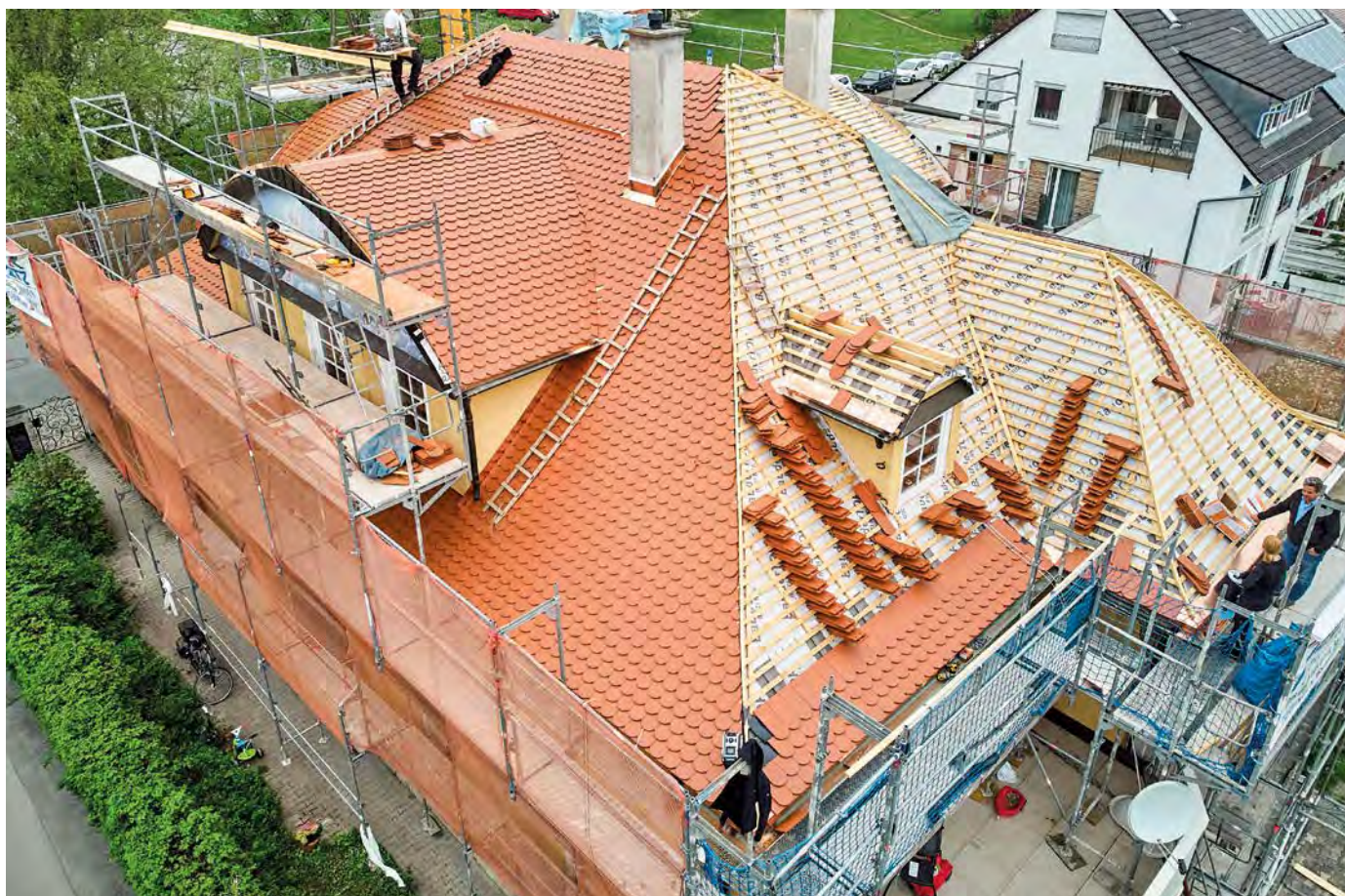
BauderPIR als Aufsparrendämmung
