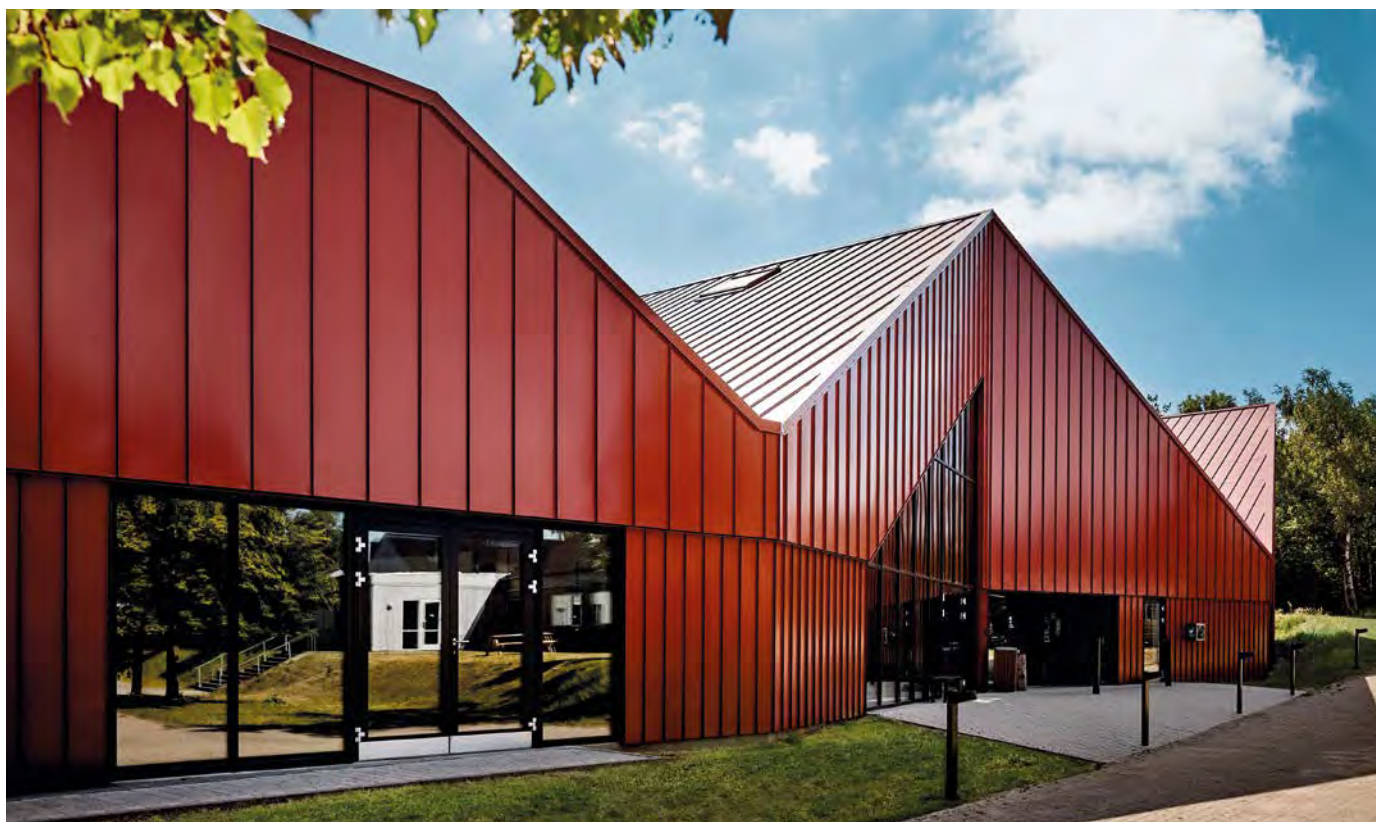
Sporteinrichtung eingedeckt und bekleidet mit der DS Nordic Klickfalz in Rot
