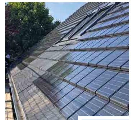
Eine dachintegrierte PV-Anlage fügt sich harmonisch in die Dachfläche ein
