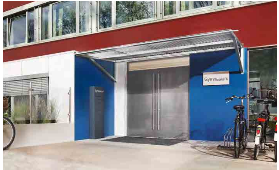
Die Fassadensanierung von öffentlichen Gebäuden ist ein wesentlicher Faktor der Bausubstanzerhaltung. Mit robusten Kronoart-HPL-Baukompaktplatten in verschiedenen Farbtönen und einer stabilen Überdachung wurden hier Wände und Eingangsbereich gestaltet.
