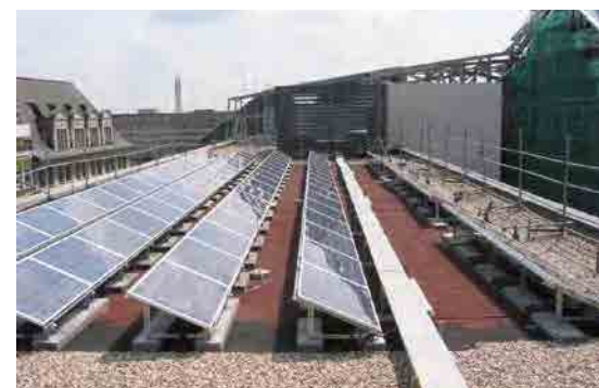
KRAITEC® step als Schutzlage unter PV-Anlagen
