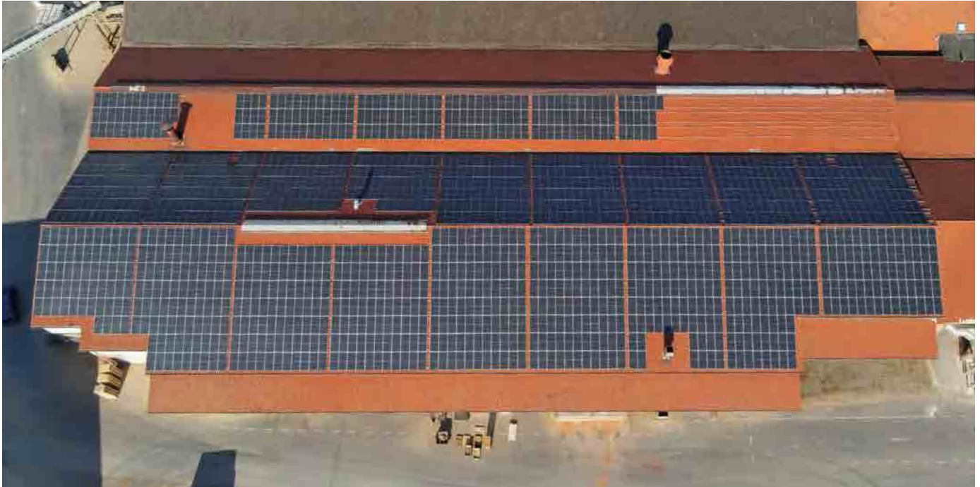
Seit einigen Monaten liefert eine PV-Anlage auf dem Hallendach des Unternehmens 16 Prozent des benötigten Stroms
