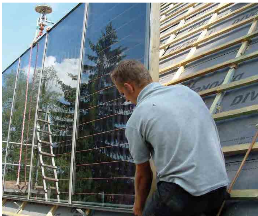
Dachdecker installieren eine PV-Anlage (Fotos: HF-Friedrich)
