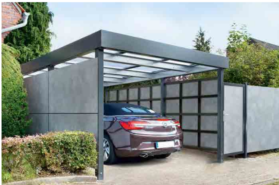
Die Einfahrt mit neuem Gesicht: mit Alucom Design-Exterieur als Seitenwand, Türfüllung und Sichtschutz wird ein Carport verkleidet. Die Aluverbundplatten mit dem Dekor Beton metallic bilden einen harmonischen Kontrast mit der Umgebung, Haus und Garten. Durchdringungen wurden ebenfalls aus der Bahn herausgeschnitten.
