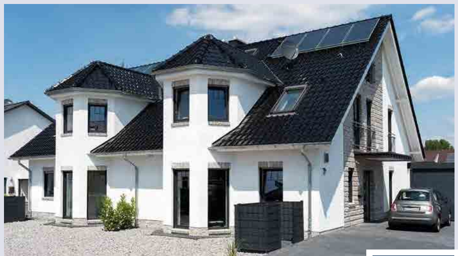
Sieht gut aus und liefert sauberen Strom: Dieses Dach ist mit dem Flachdachziegel TIEFA XLTOP (Nr. 50) gedeckt
