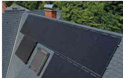
Die Energie der Sonne kann auf fast jedem Hausdach zur Stromgewinnung beitragen
