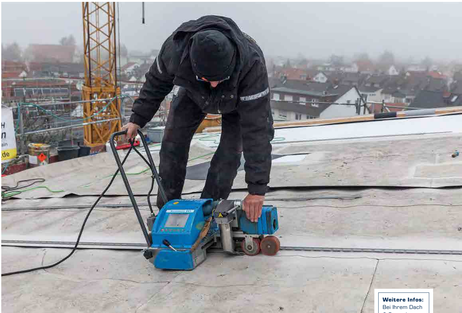
Die Nahtfugung findet mit einem Schweißautomaten aus dem auf die Bahn abgestimmten Zubehörsortiment statt
