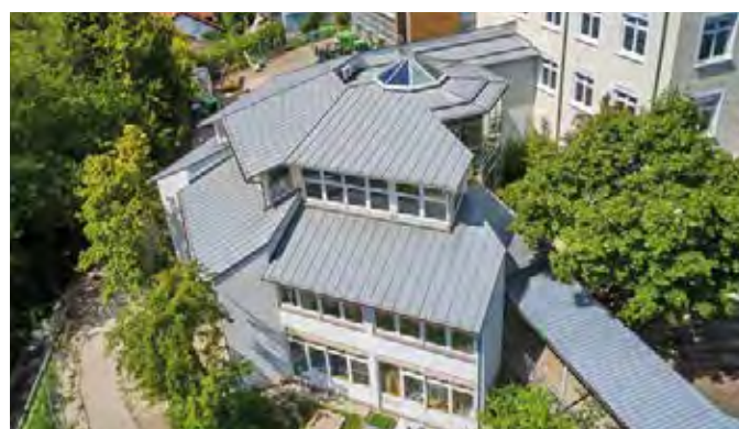
Jakob-Gretser Schule, Markdorf, Deutschland, verlegt mit Rhepanol hfk-bs
