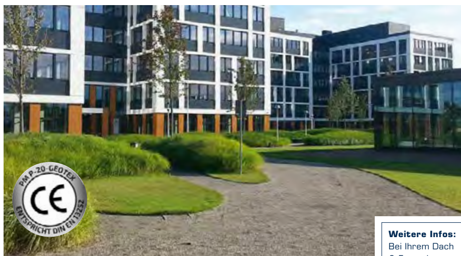
PM P-20-GEOTEX im Praxiseinsatz auf einer begrünten Tiefgaragendecke
