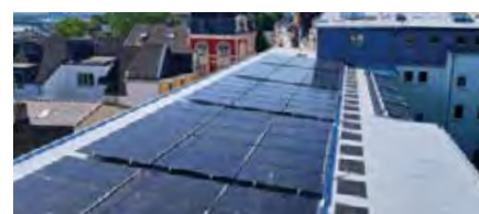
Blick auf das sanierte Dach mit der neuen PV-Anlage
