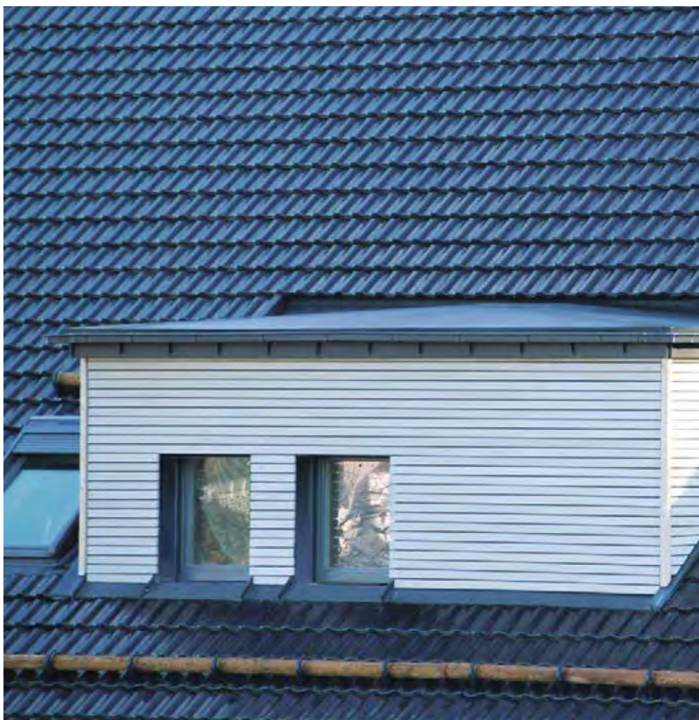
Die Herausforderung ist der Übergang vom Steildach auf die Gaube
