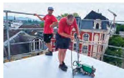
„Lupendichte“ Nahtfügung der Dachbahnen mittels Heißluft-Schweißautomat
