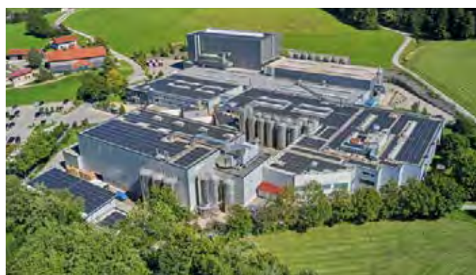
EK-Pack Folien GmbH, Wiggensbach, Deutschland, verlegt mit Rhepanol hfk
