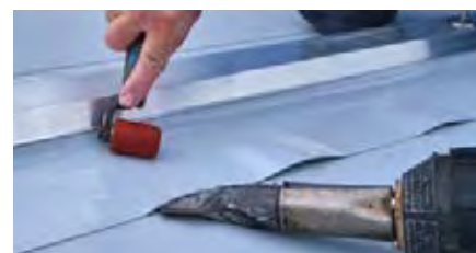
Die Montageschiene wird materialhomogen mit der Abdichtung verschweißt
