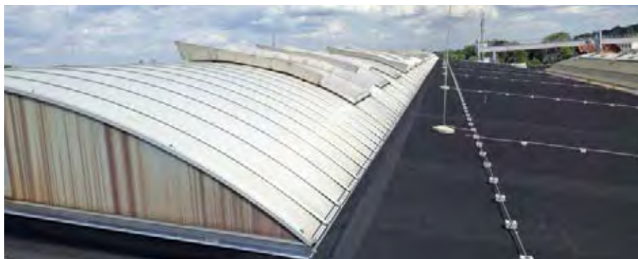
Sanierung eines Industriedaches in Sandwichform mit der partiell selbstklebenden EPDM-Bahn RESITRIX® SK Partial Bond – eventuell eingeschlossene Restfeuchte kann ungehindert entweichen
