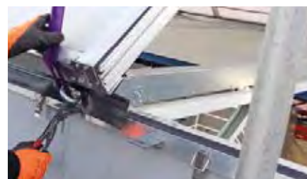
Vor dem Abnehmen der Lichtband-Oberschale musste der Demontagerahmen ordnungsgemäß demontiert und mit einem Seil gesichert werden
