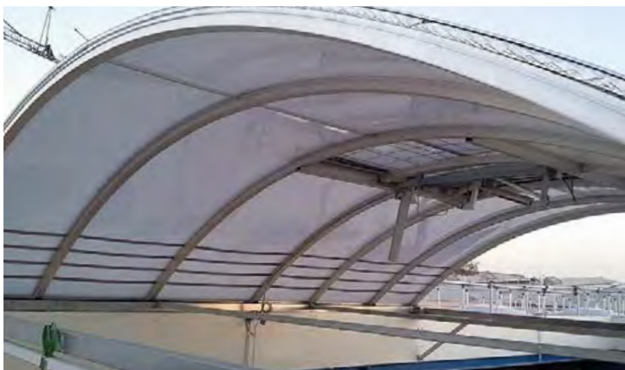
Zum Einsatz kam das Kingspan ESSMANN Lichtband basic mit pneumatischem NRW F6 sowie Ab- und Durchsturzicherungen ID 1200 und EAD
