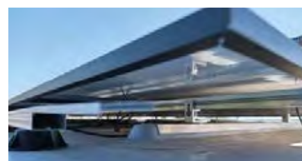
Die Befestigung von Modultragprofilen zur Aufnahme von Solarmodulen erfolgt am Rapid-Systemverbinder direkt auf der Montageschiene
