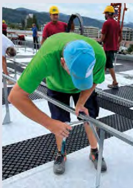
Die Modultragschienen können waagrecht aufgelegt werden, ohne herunterzufallen. Danach werden sie befestigt.
