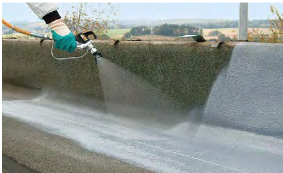
MB PUReactive+ lässt sich im Spritzverfahren applizieren, das Produkt ist bereits faserarmiert und bietet eine Flächenleistung von bis zu 150 Quadratmetern pro Stunde
