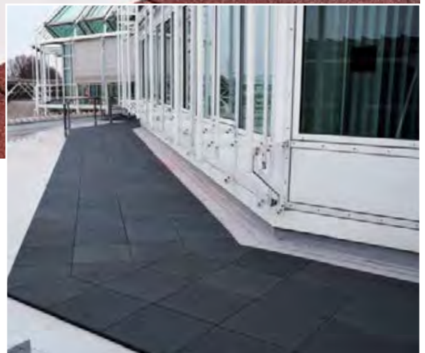
Wartungsweg am Flughafen München
