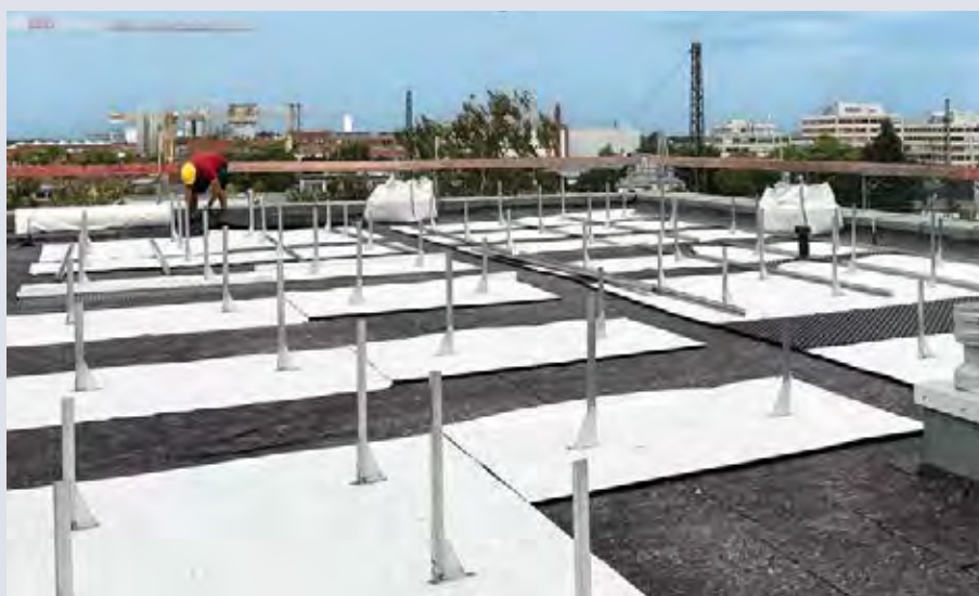
Auf den zum PV-System gehörenden Wasserspeicherplatten ist das Vlies bereits aufkaschirt. In den Zwischenräumen werden die nach Bedarf zugeschnittenen Speicherelement-Platten und das Filtervlies aus dem SOPREMA Gründachsystem verlegt.
