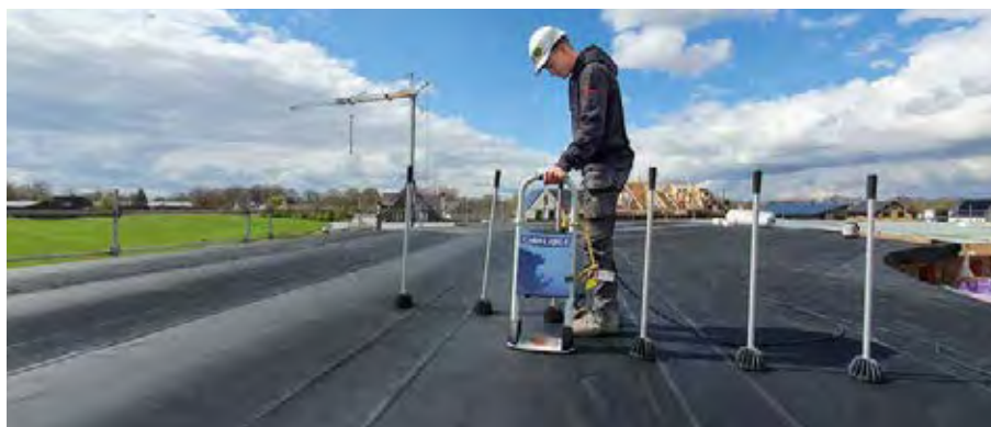
Durchdringungsfreie Verlegung von HERTALAN® EPDM-Planen mittels Induktion – sogar direkt auf PVC-Altabdichtungen möglich
