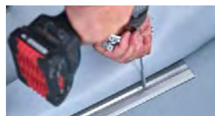
Die Montageschiene wird mit zugelassenen Dachbauschrauben in der Tragschicht verankert
