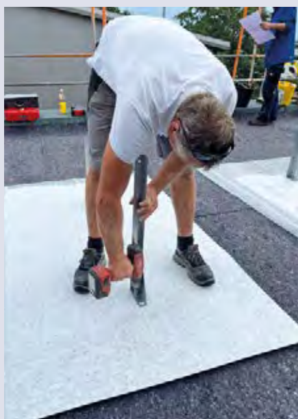
Die Stützen sind vormontiert; sie lassen sich einfach in der Grundschiene einhaken und festziehen
