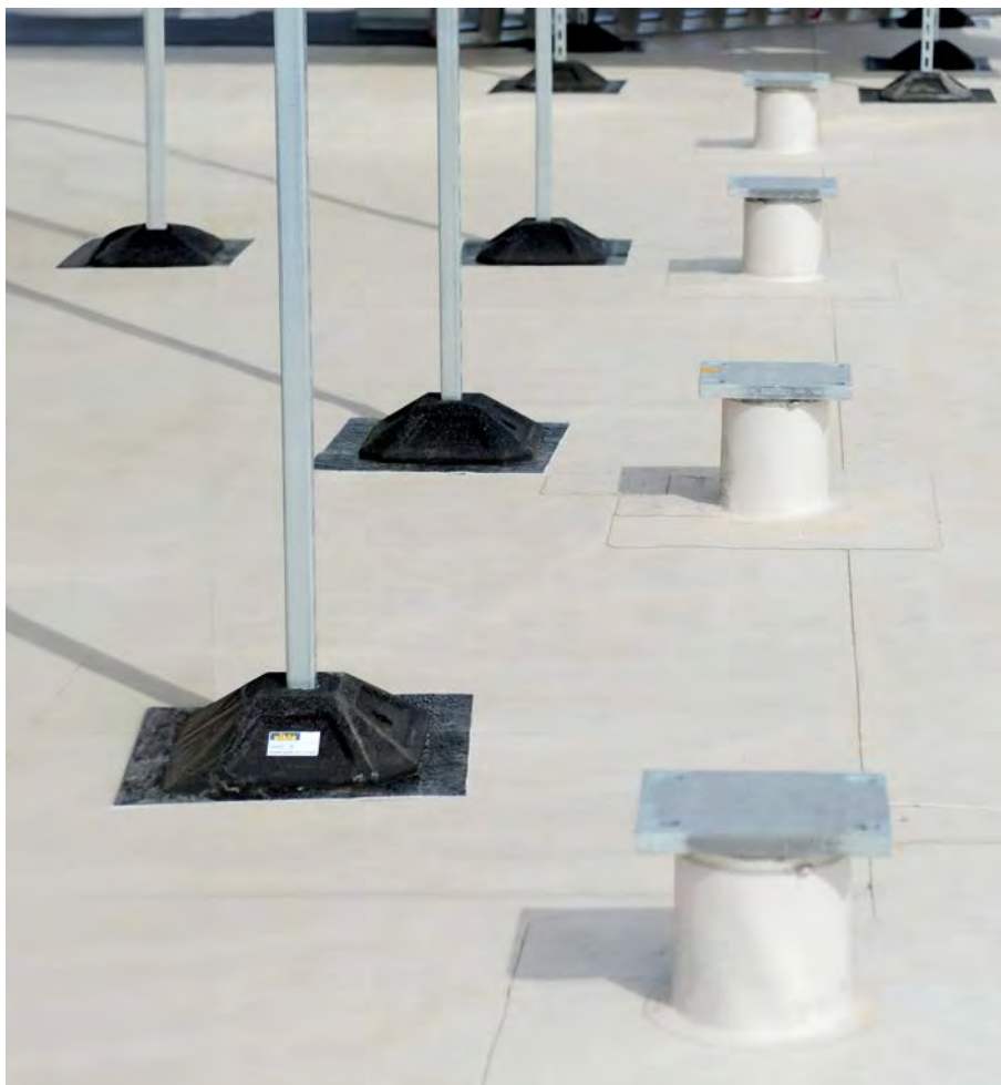
Auf den Dächern mussten zahlreiche Durchdringungen mit Sarnafil®-Formteilen eingefasst werden
