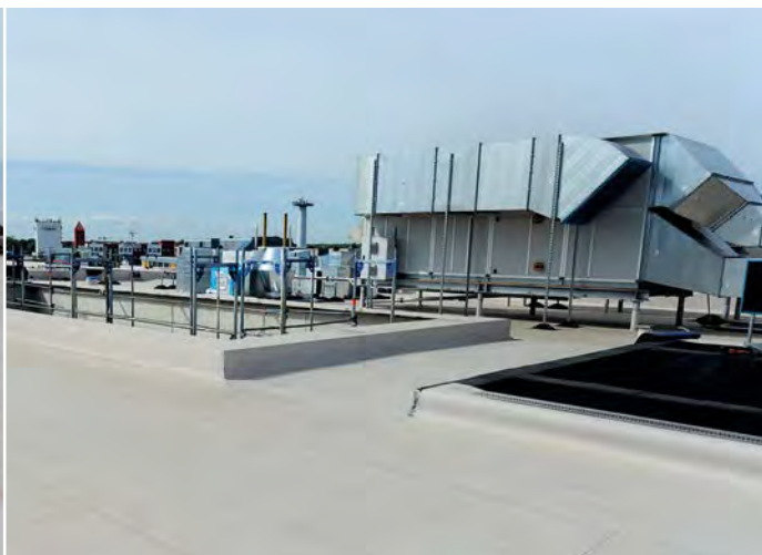
Im Überdeckungsbereich wurde Sarnafil® TS 77-18 mechanisch befestigt (Saumbefestigung)
