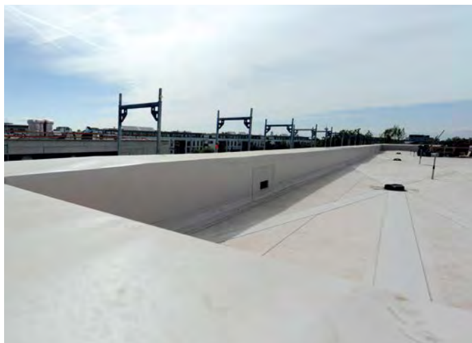
Im Attikabereich wurden Verbundbleche als luftdichter Anschluss angebracht
