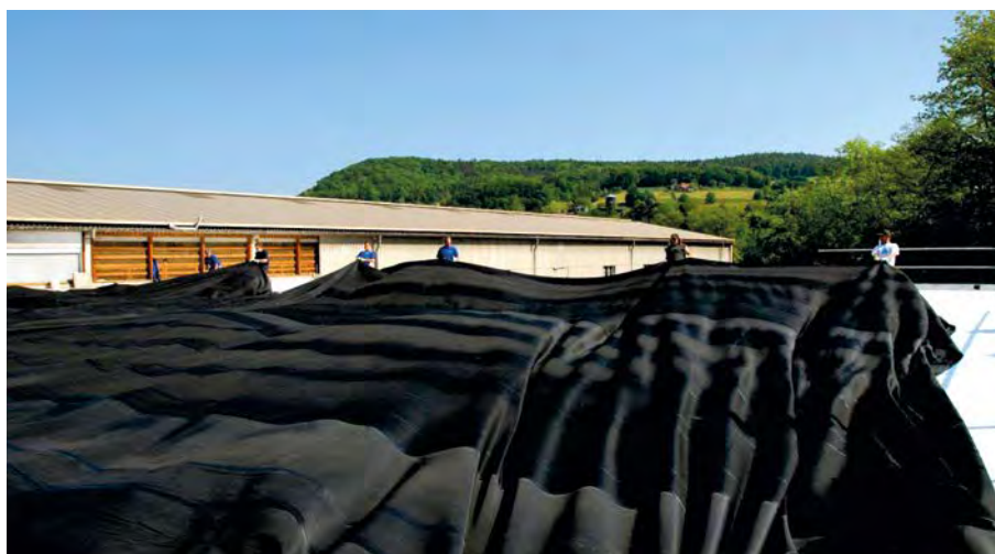
Dachabdichtung in einem Stück – im CARLISLE® Werk können EPDM-Planen von bis zu 1.000 m² Größe vorgefertigt werden
