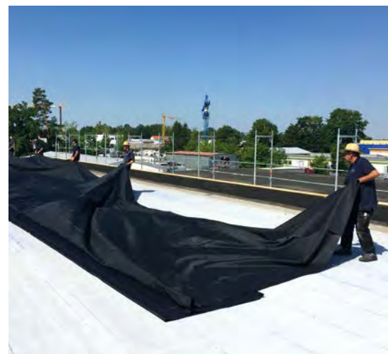
Die HERTALAN® EPDM-Planen sind sogar zur Direktsanierung auf PVC-Alt-dächern geeignet
