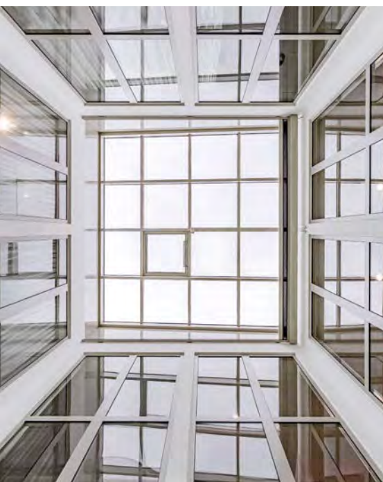
Atrium-Glasdach mit BA Pfosten-Riegel-System in der Glemstalschule Schwieberdingen-Hemmingen (Foto: Boris Storz)
