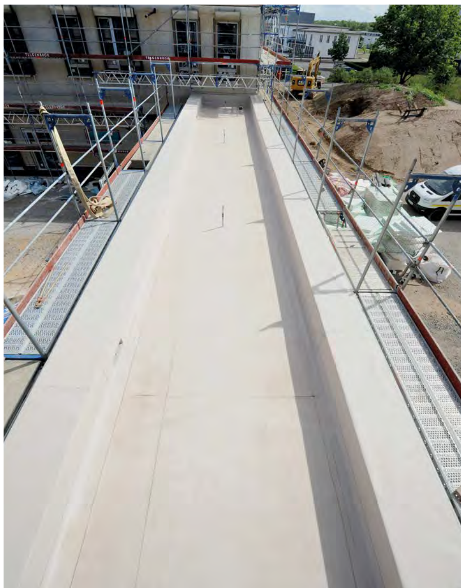
Auf die Gefälledachkonstruktion der Verbindungstrakte wurde ebenfalls Sarnafil® TS 77-18 verlegt
