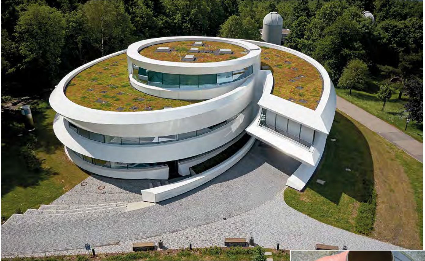
Regenrückhaltung und Entwässerung im Schneckentempo, dank Dachbegrünung und Sita Retention (Foto: Bauder)
